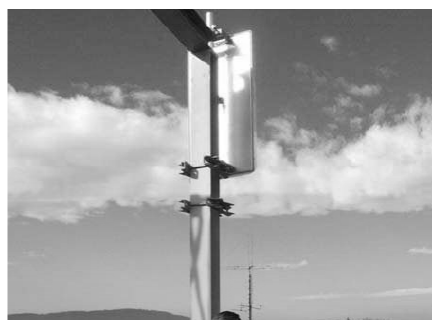
Slika 3. DVB-T predajnik i predajna antena u Gracu
